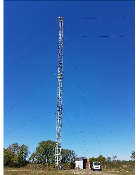
Mât météorologique de 60 m du Centre de Recherches Atmosphériques à Lannemezan, sur lequel sont installés détecteur gamma et instruments de mesure du radon. En arrière-plan, le Pic du Midi où est installé un autre détecteur de radon.
